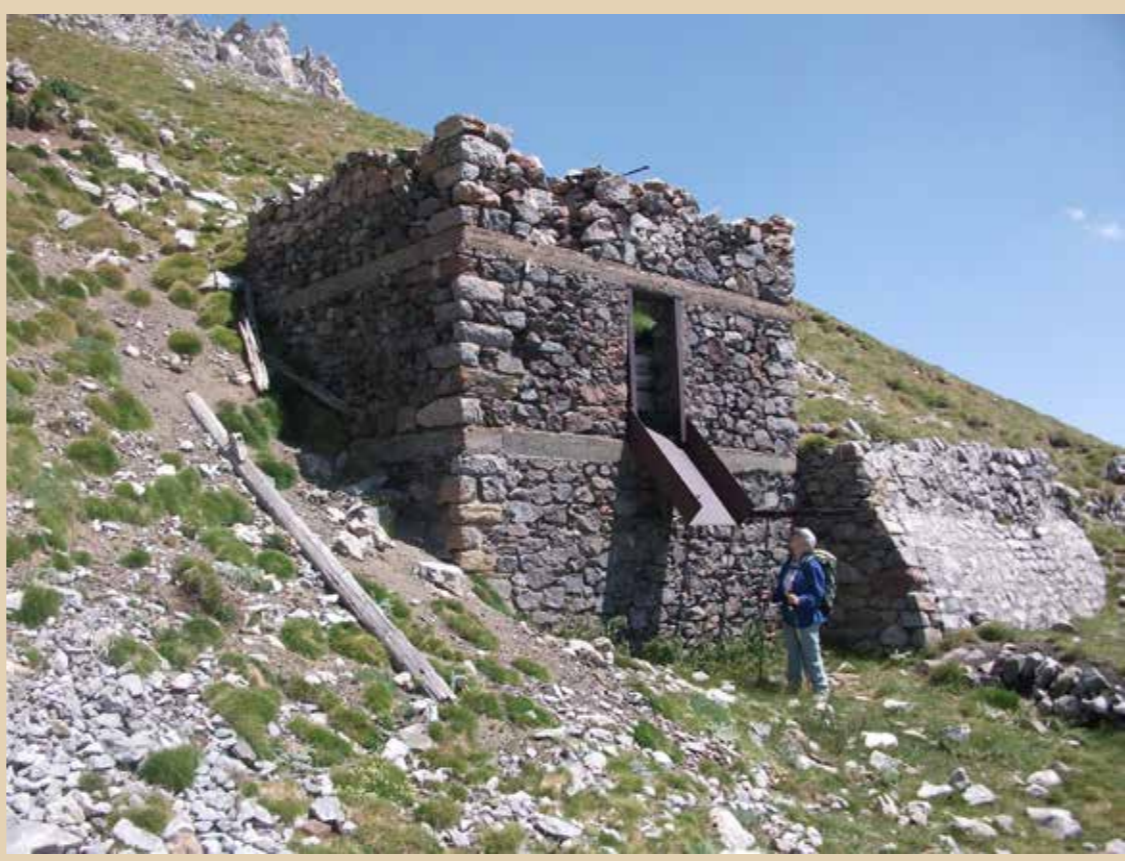
Restes d'un telefèric que portava el mineral fins la tremuja, punt on es carregava en un petit camió.
